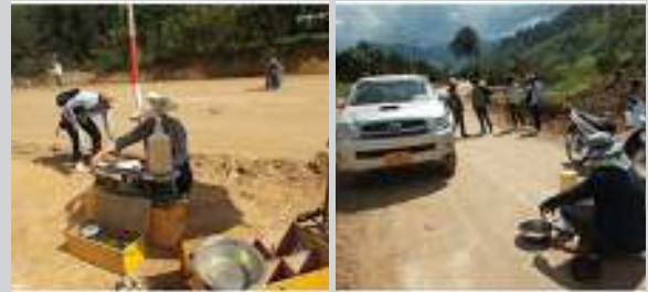
ศูนย์วิศวกรรมโยธา : ทดสอบและตรวจสอบวัสดุทางวิศวกรรมโยธา โครงการก่อสร้างถนนจากบ้านฮวก (พะเยา) - เมืองคอบ - เมืองเจียงฮอน (สปป.ลาว) (กันยายน 2557)
